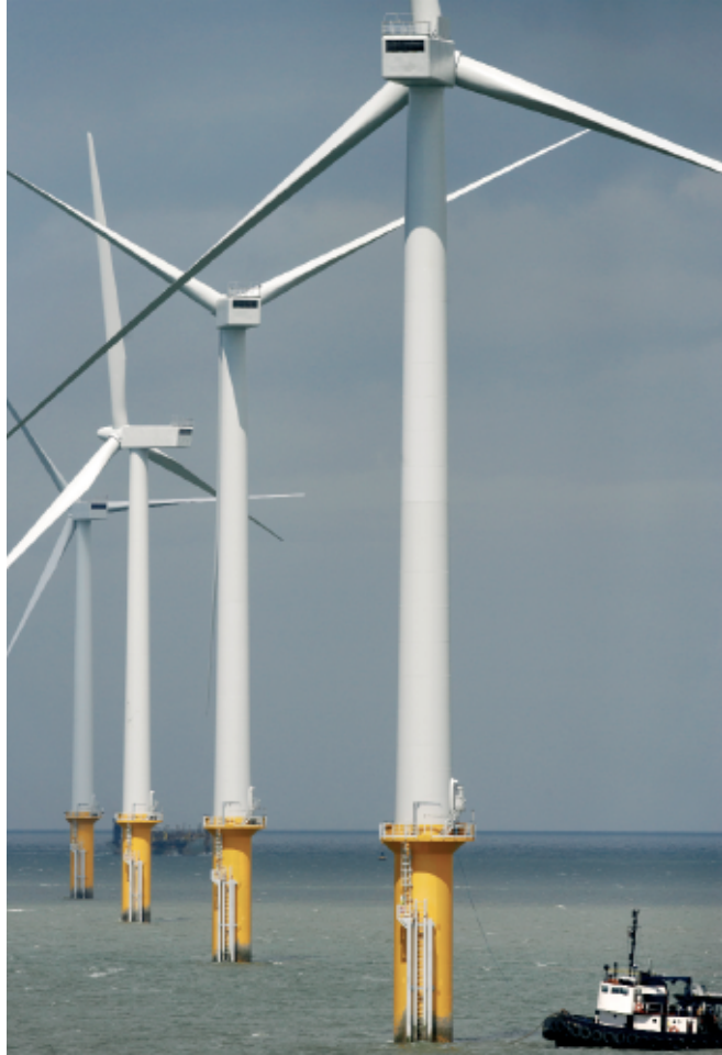
Der Offshore-Windpark Burbo vor der Küste Liverpools mit 25 Windturbinen von Siemens Energy. Die Windkraftanlagen des Typs SWT-3.6-107 mit einer Leistung von jeweils 3,6 Megawatt wurden in weniger als anderthalb Monaten errichtet und damit schneller als erwartet. Der Windpark hat eine Leistung von 90 Megawatt und kann mehr als 80.000 Haushalte mit umweltfreundlichem Strom versorgen.
